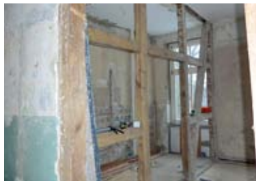
Sanierung einer Wohnung
