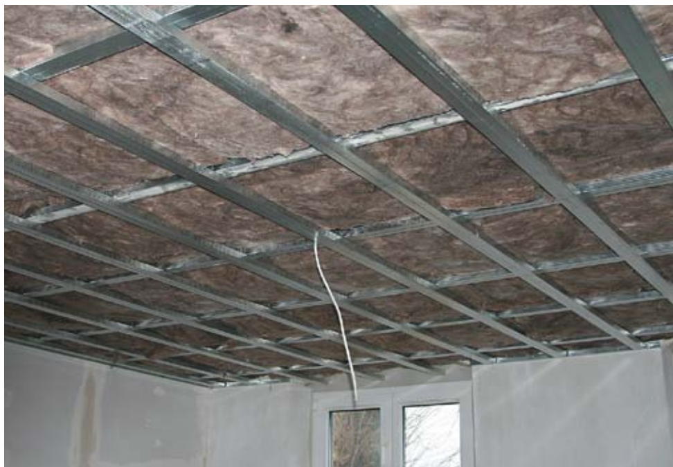
Sanierung einer Leerwohnung
