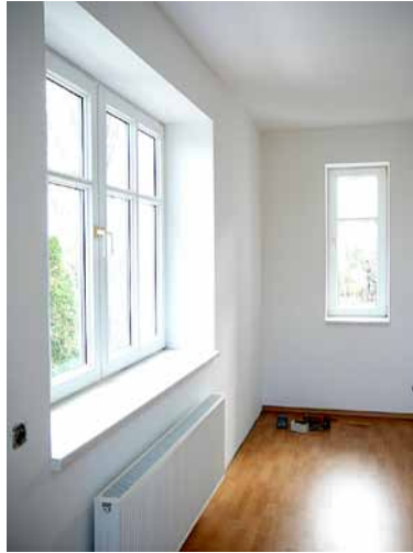
Sanierung einer Wohneinheit in Loissin, Am Park 1
