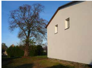
Außensanierung des Objektes Vierow, Am Anger 4
